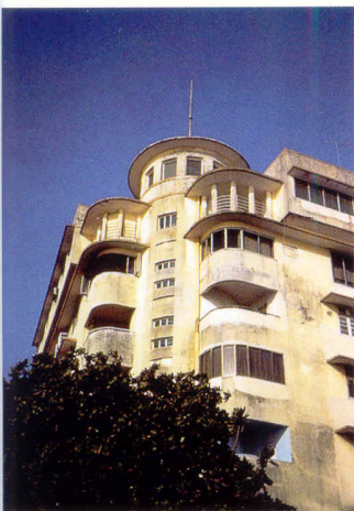
Здание на Приморском шоссе. Бомбей, 1940. Такие дома и отели украшали город со стороны моря, придавая Бомбею вид западного города, похожего на Майами.
