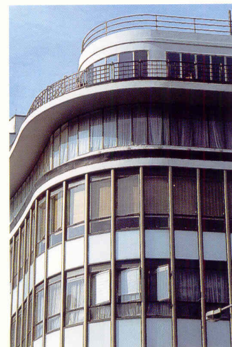
У. Крабтри при консультациях Слейтера, Моберли и Рейли. Универмаг «Питер Джоунс». Фрагмент закругленной крыши. Лондон, 1936. Здание проектировалось с учетом неудобной конфигурации места строительства. Фасад из стекла и стали – символ радикального отхода от прежней практики строительства больших магазинов так, чтобы снаружи они выглядели как ряд небольших помещений.
